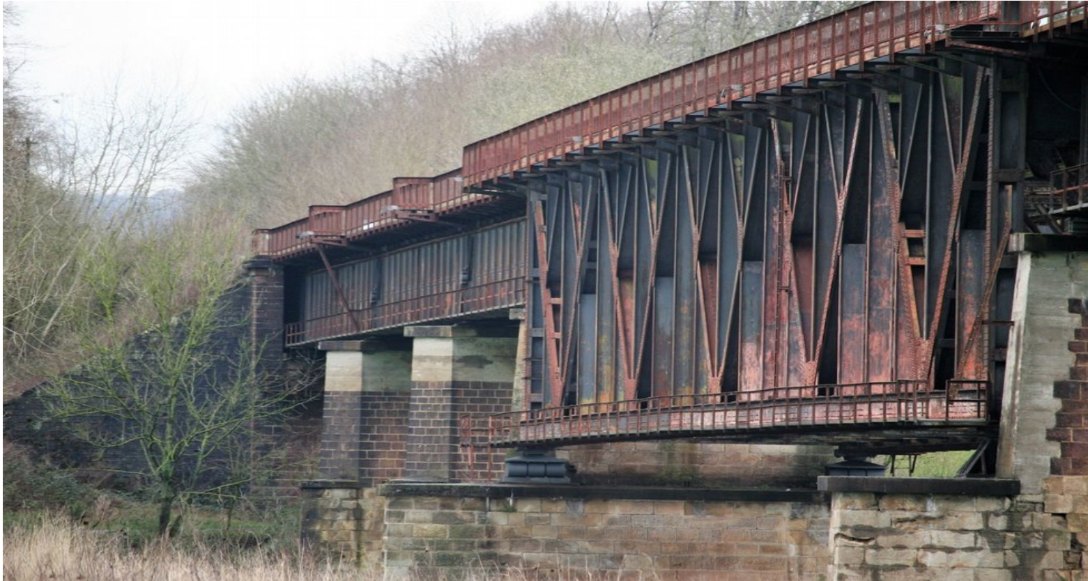
Brückenbauwerk nahe Beverungen, Baujahr 1878
