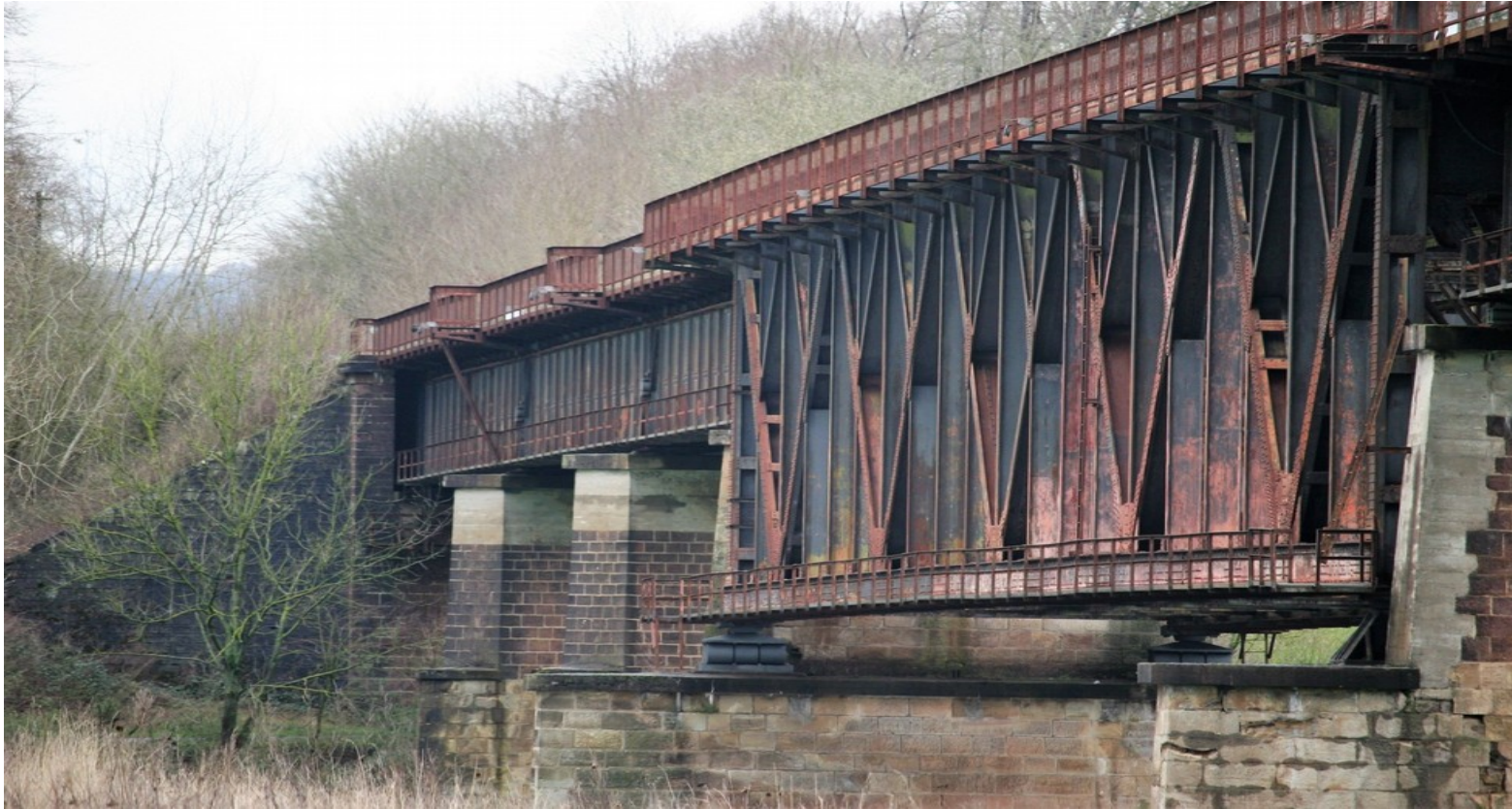
Brückenbauwerk nahe Beverungen, Baujahr 1878
