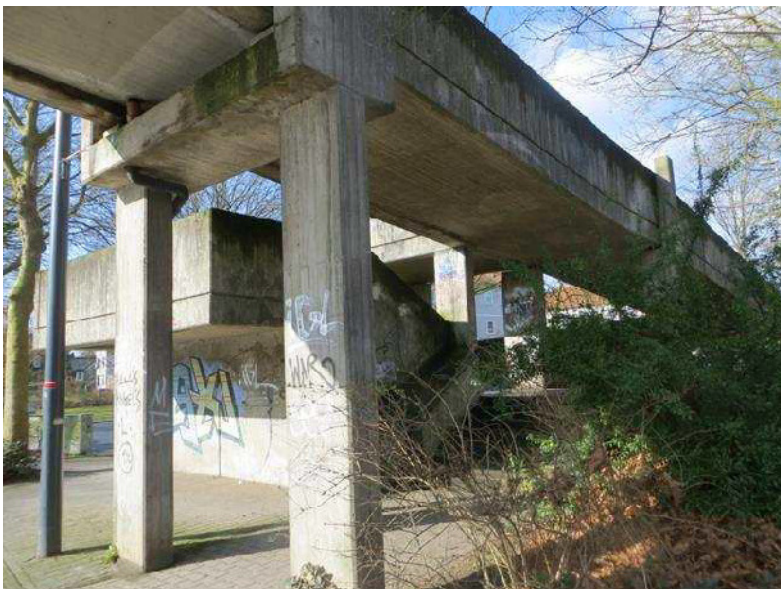
Abbildung 19: Überführung über B61 zwischen Ohlbrocksweg und Johann-Sewerin-Straße
