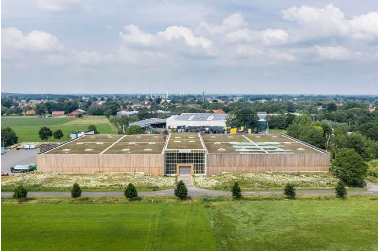
Abbildung 0-1: Gewerbehalle Lütvogt in Wagenfeld. Foto: Schaffitzel Holzindustrie/Architekturfotografie Steffen Spitzner
